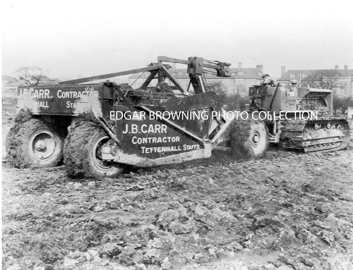
Således har BW-4s Caterpillar D8 trukket Carryall Scraper'en rundt på Marraq-sletten. (Foto: Edgar Browning)
