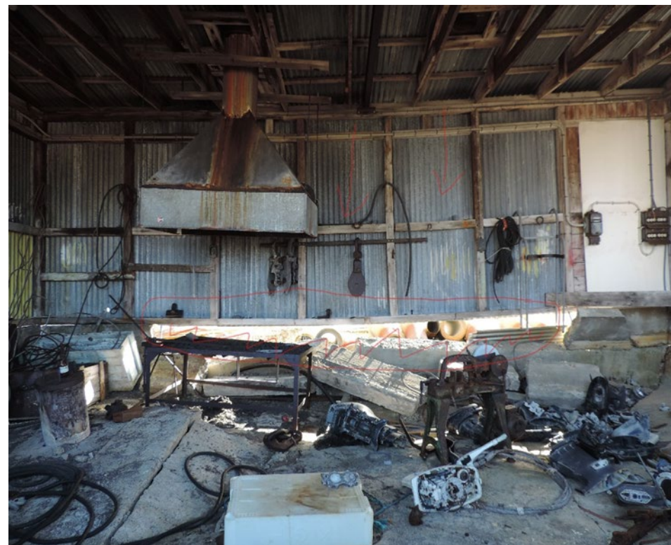
Figur 0.2 Ildsmedje B-9 interiør. Loftet synker sammen, pga. manglende fundament
