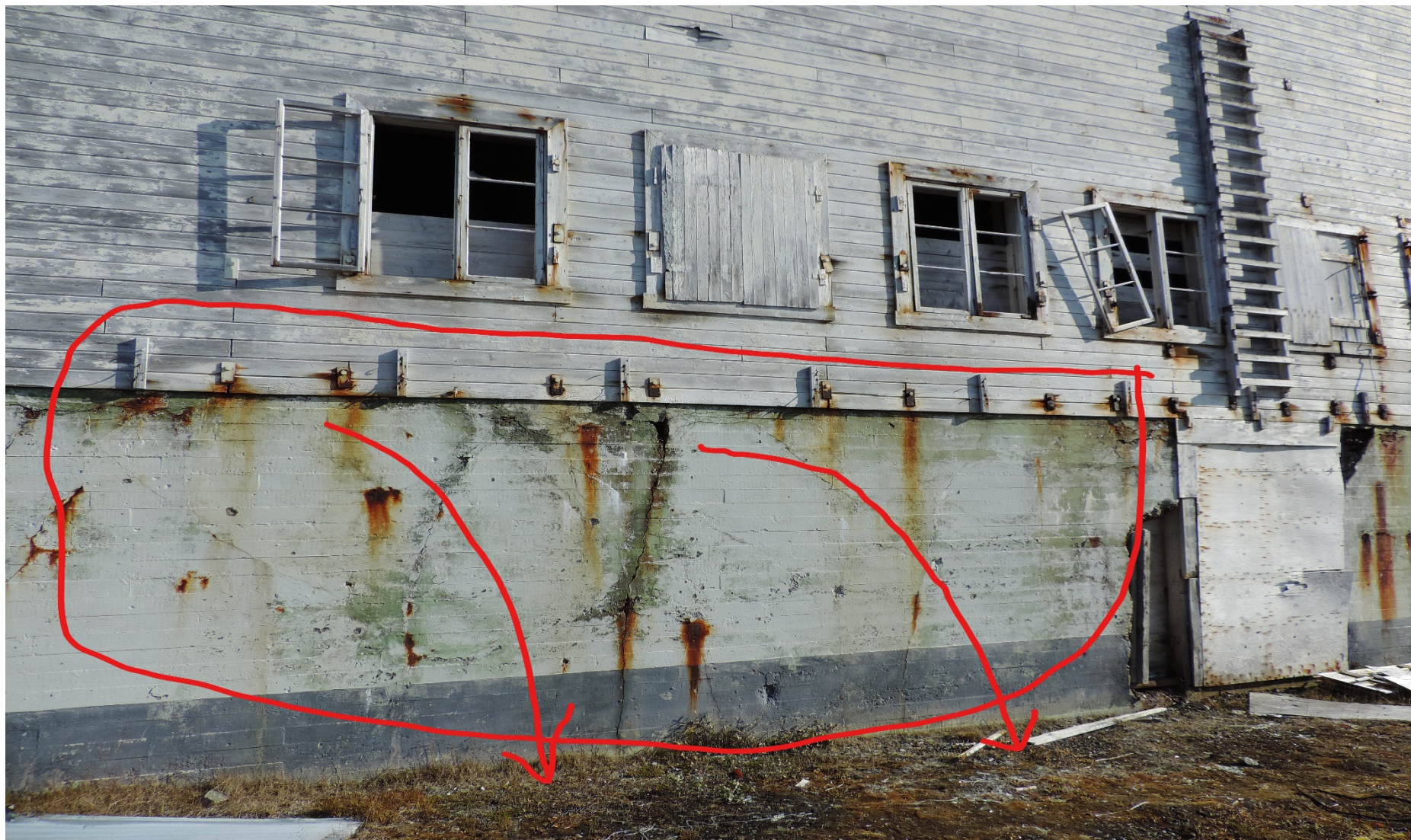
Figur 0.15 Saltsilo B-20. Armeringen i betonmuren er tæret og den svækkede mur revner og buler udad. Fare for sammenstyrtning.
