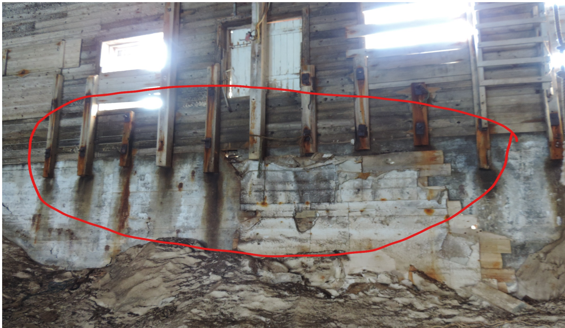
Figur 0.14 Saltsilo B-20. Endegavl indefra. Saltet tærer boltene i gavlens mangelfulde befæstning på den høje betonmur.
