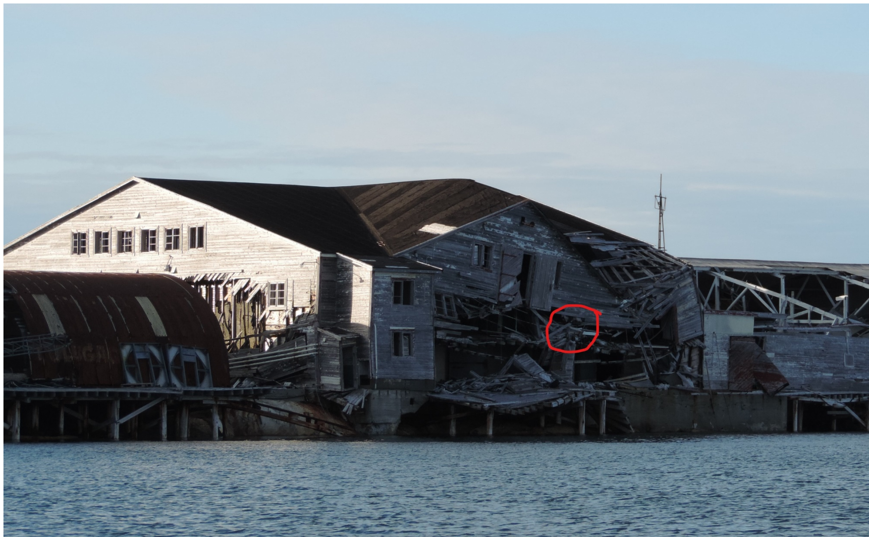
Figur 0.8 Fryseri og trawlloft B-18. Samme bygning udefra. Markering viser den stolpe, der holder konstruktionen.
