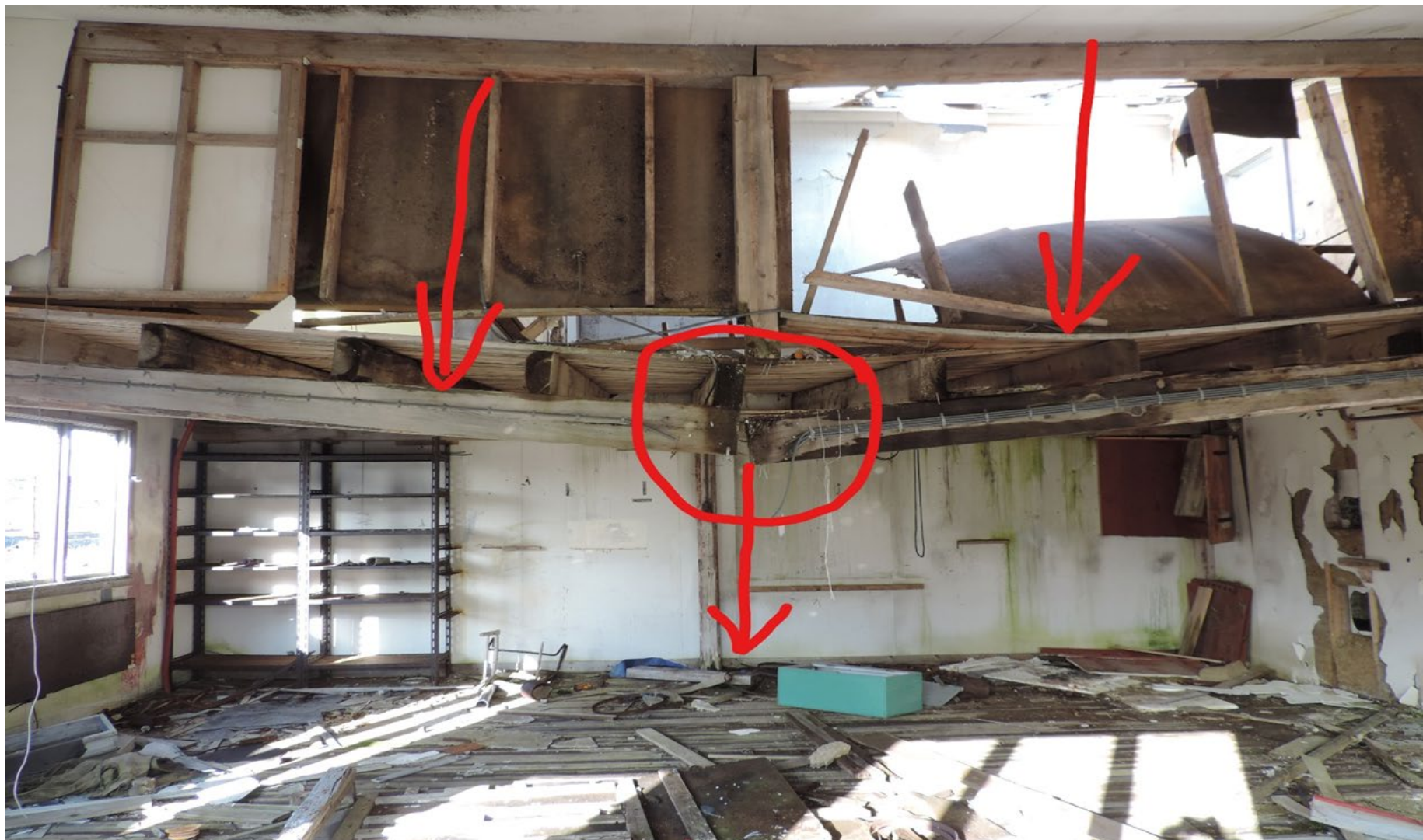
Figur 0.3 Frysehus og lager B-8. Bjælkelag uden støtte synker sammen, og 1. sal kollapse
